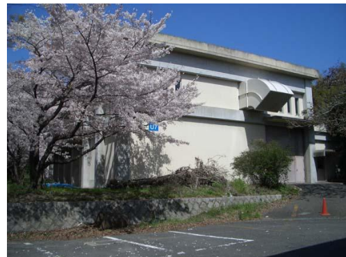
写真1 風洞実験棟外観
