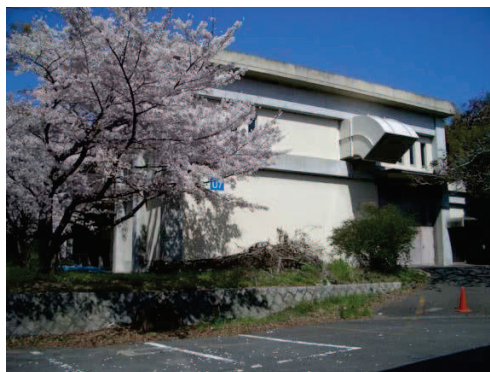
写真1 風洞実験棟外観
